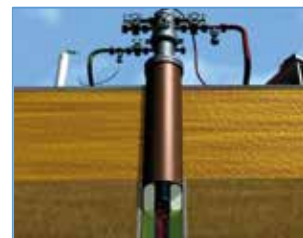
Fig.4 Inyección de CO 2 líquido
